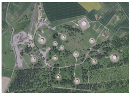
SAINT-BAUSSANT / IMPORTANT DÉPÔT D'HYDROCARBURES
