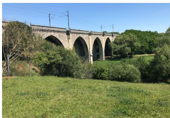
EUVEZIN – PHOTOGRAPHIE DU VIADUC
