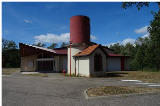
THIAUCOURT-REGNIÉVILLE - SALLE CULTURELLE DANS L'ANCIENNE GARE
