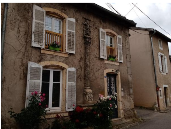
ONVILLE – HABITATION INTÉGRANT UNE CROIX EN FAÇADE
