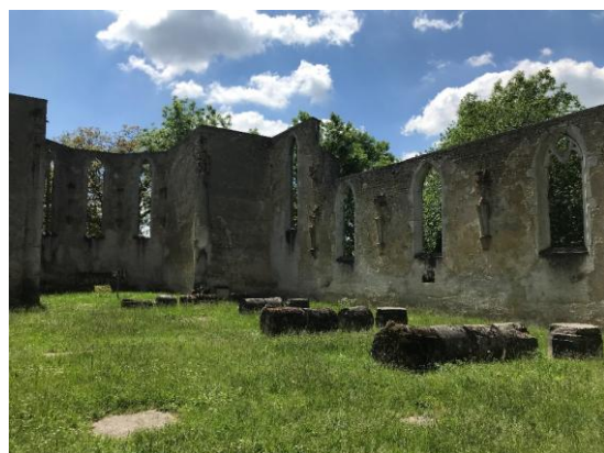
FLIREY – VESTIGES DE L'ANCIENNE ÉGLISE
