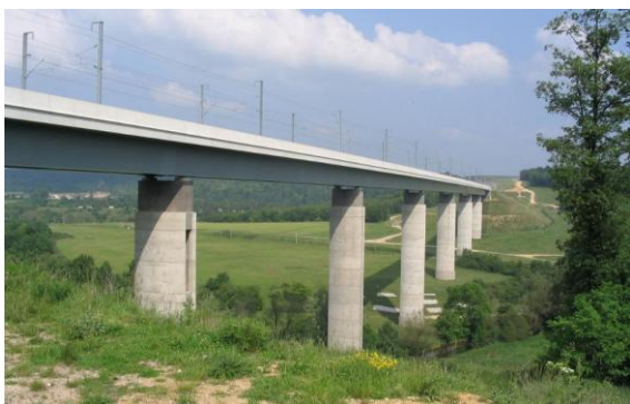
Jaulny - Viaduc de la ligne grande vitesse Source : STRUCTURAE.NET
