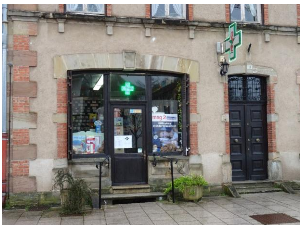
NOVÉANT-SUR-MOSELLE — PORTE COCHÈRE RECONVERTIE EN VITRINE DE COMMERCE
