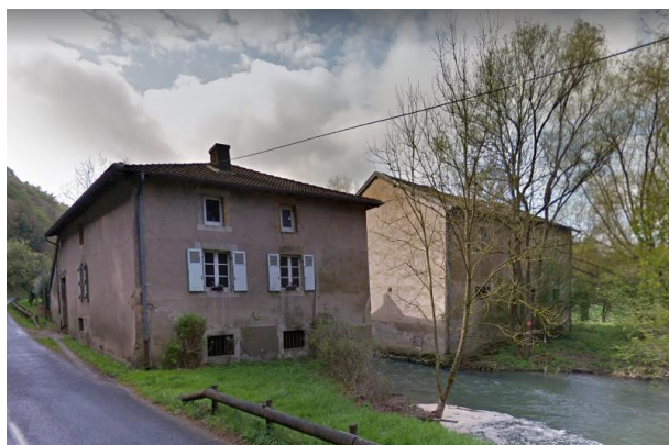
JAULNY- MOULIN À EAU AU NORD DU VILLAGE
