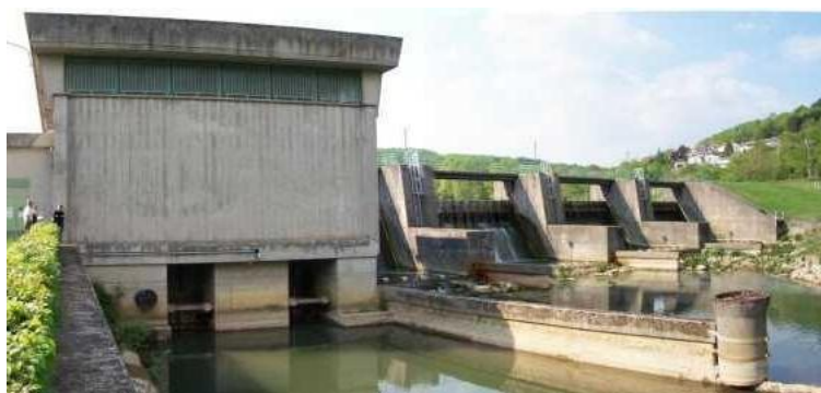
ARNAVILLE - BARRAGE DU RUPT DE MAD
