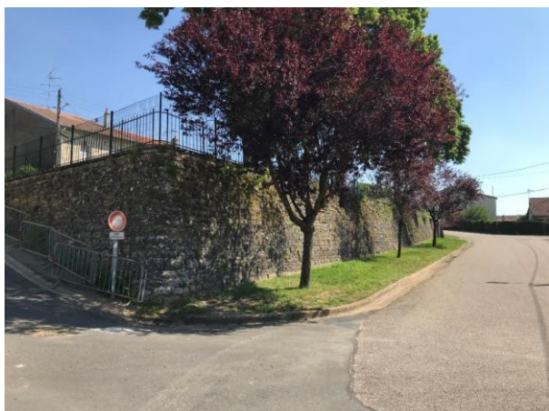
MAMEY – MUR DE SOUTÈNEMENT BIEN ENTRETENU
