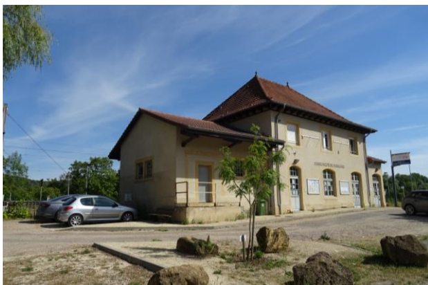
ANCY-DORNOT - ANCIEN BÂTIMENT VOYAGEURS DE LA GARE
