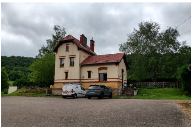
REMBERCOURT-SUR-MAD - ANCIENNE HALTE FERROVIAIRE
