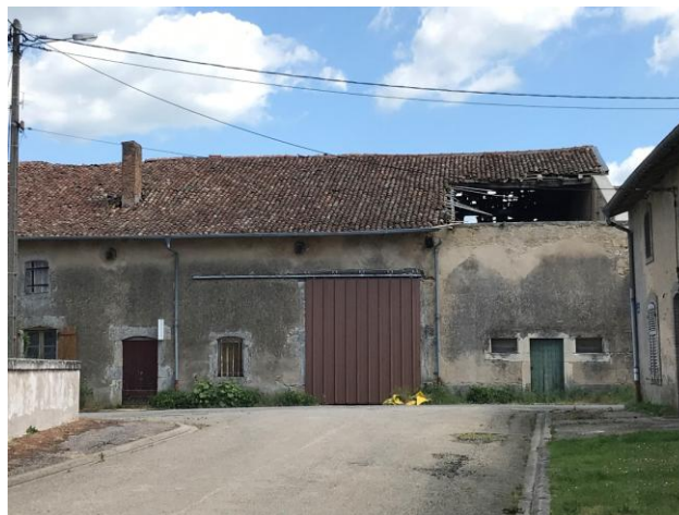
HAMONVILLE – EXEMPLE DE BÂTI DÉGRADÉ DU VILLAGE HISTORIQUE
