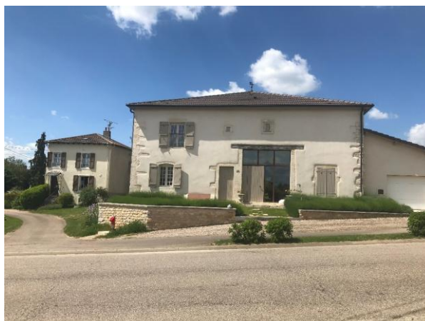
BERNÉCOURT — RÉINTÉGRATION D'UN PORTE DE GRANGE LORS DU RAVALEMENT DE FAÇADE
