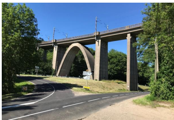
WAVILLE – VUE DU VIADUC DEPUIS LA RD28
