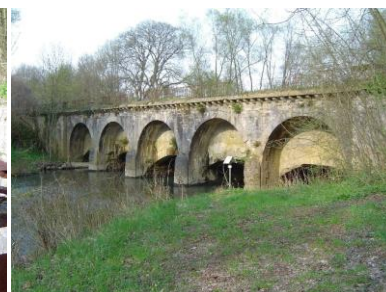
L'OUVRAGE DU PONT CANAL
