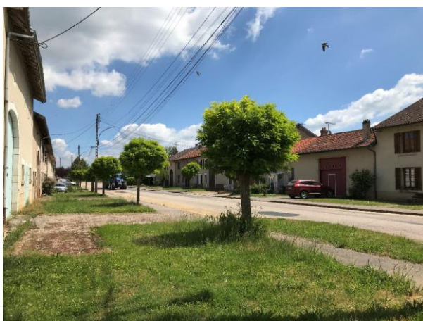
FLIREY –USOIRS RÉAMÉNAGÉS LORS DE LA RECONSTRUCTION
