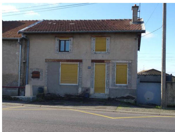
MARS-LA-TOUR — RÉDUCTION DES OUVERTURES EN FAÇADE
