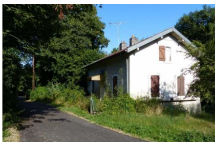
ARNAVILLE - MAISON ÉCLUSIÈRE
