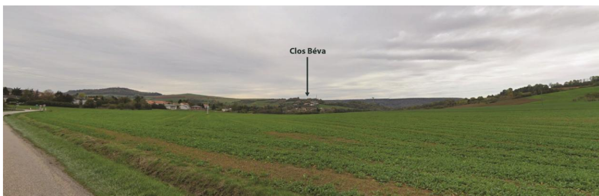
CORNY-SUR-MOSELLE – IMPLANTATION DU « CLOS BÉVA » SUR LE COTEAU, VUE DEPUIS LA RUE D'AUGNY SOURCE : GOOGLE STREET
