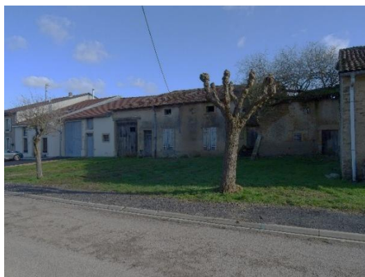
UN BÂTI ANCIENNEMENT AGRICOLE AUJOURD'HUI DÉGRADÉ (HANNONVILLE-SUZÉMONT)
