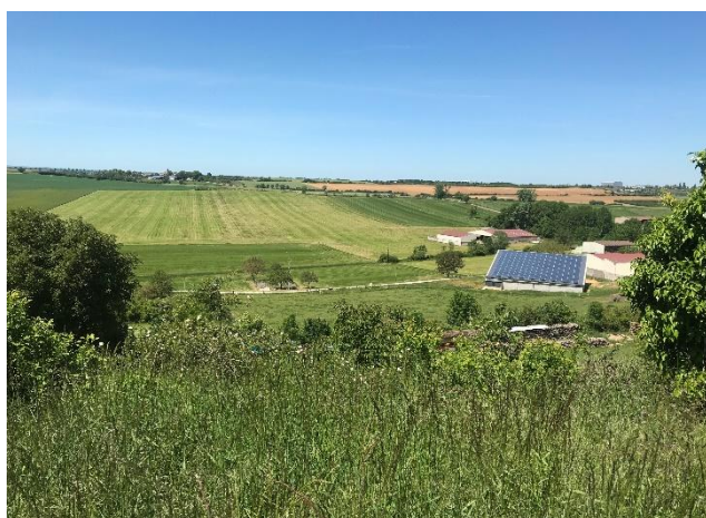
PANNEAUX SOLAIRES PHOTOVOLTAÏQUES, CHAREY
