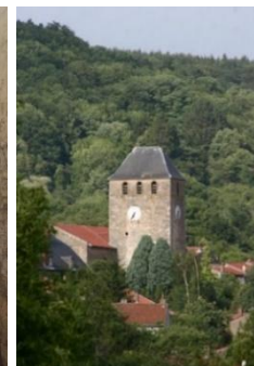
ÉGLISE SAINT-RÉMY — ONVILLE SOURCE : AGURAM 2020
