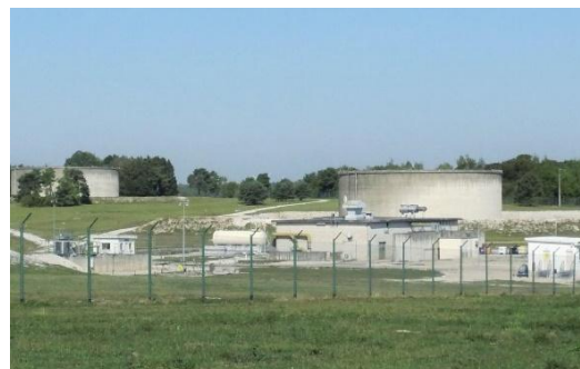
DÉPÔT DE LIQUIDE INFLAMMABLE DE SAINT-BAUSSANT SOURCE : L'UNION 2019
