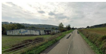
SITE EN FRICHE AU NIVEAU DE L'ENTRÉE DE VILLAGE DE VILCEY-SUR-TREY — SOURCE :
