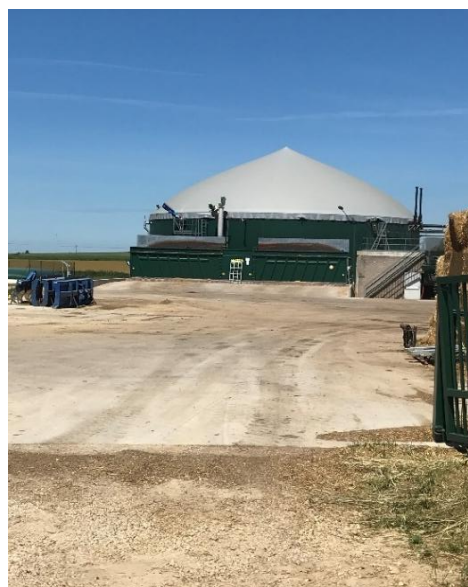
UNITÉ DE MÉTHANISATION À HAGÉVILLE SOURCE : AGURAM 2020
