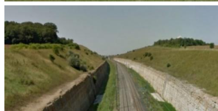
VIADUC DE JAULNY (SCOTAM) ET DÉBLAI/REMBLAI LE LONG DE LA LIGNE LGV (GOOGLE)
