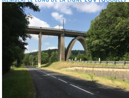
VIADUC DE WAVILLE SOURCE : AGURAM 2020
