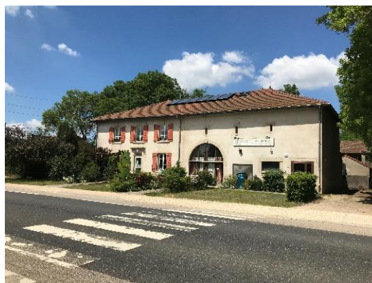
PANNEAU SOLAIRE PHOTOVOLTAÏQUE INSTALLÉS SUR UNE HABITATION À BEAUMONT – SOURCE : AGURAM 2020
