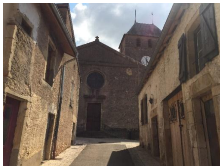
ÉGLISE SAINT-RÉMY — ONVILLE SOURCE : AGURAM 2020
