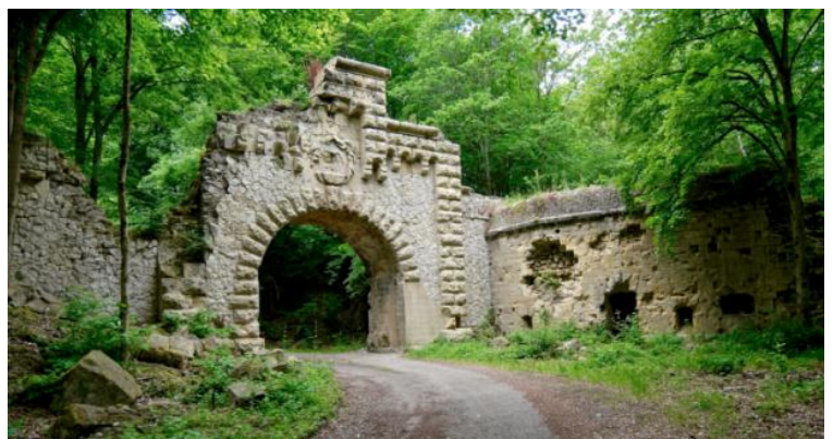
ENTRÉE DU GROUPE FORTIFIÉ DE DRIANT – SOURCE : AMICALE DU FORT DRIANT
