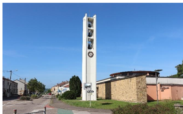
EGLISE SAINT-MARTIN-L'ÈVEQUE DE CORNY-SUR-MOSELLE
